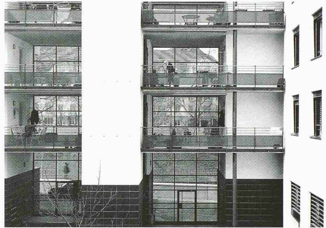
2 Die lärmexponierte Seite ist durch Erschliessungstrakte und verglaste Wohnterrassen gegen den Strassenlärm abgeschirmt. Siedlung Selnau, Zürich. Martin Spühler, Architekt, Zürich (Bild: Christian Kurz, Zürich)
