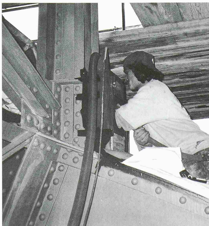
15 Sandstrahlen in Miniholzeinhausung
