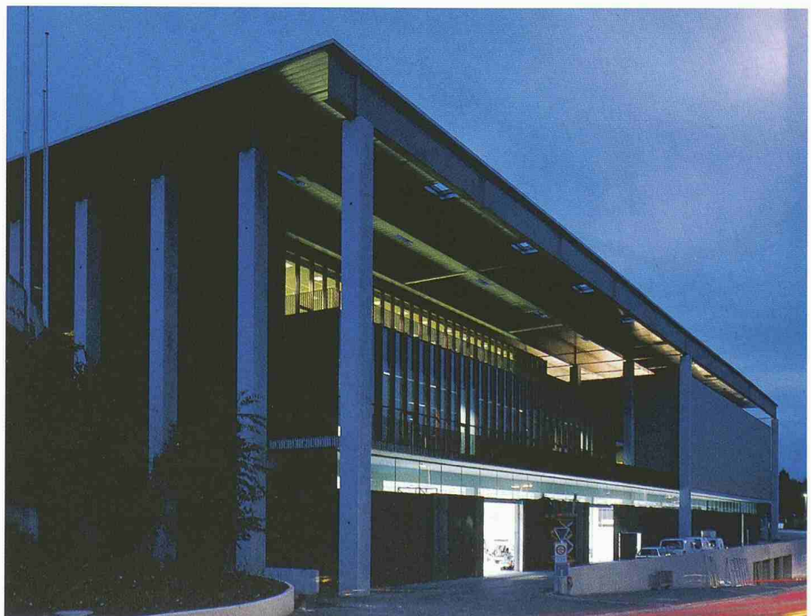
Blick von Südwesten (Bild: Eduard Hueber, New York)
