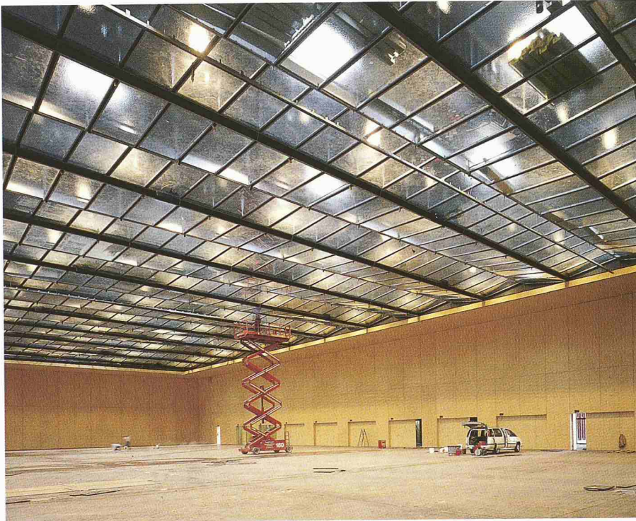
Innenansicht der Halle 9.1 (Bild: Eduard Hueber, New York)
