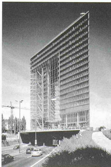
Düsseldorfer Stadttor, 1991–97. Architekten: Petzinka Pink und Partner (Bild: Joseph Gart- ner & Co.)
