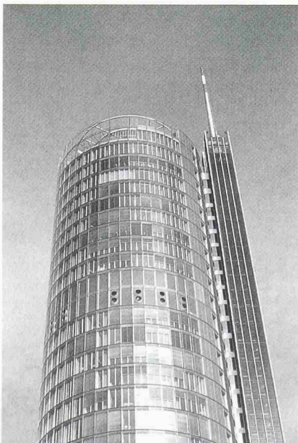
RWE-Hauptverwaltung. Essen, 1991–97. Archi- tekten: Ingenhoven Overdiek und Partner (Bild: Andrea Compagno)
