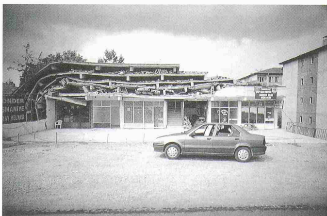
5 Komplettes Versagen eines Gebäudes («pancake»-Schaden)
