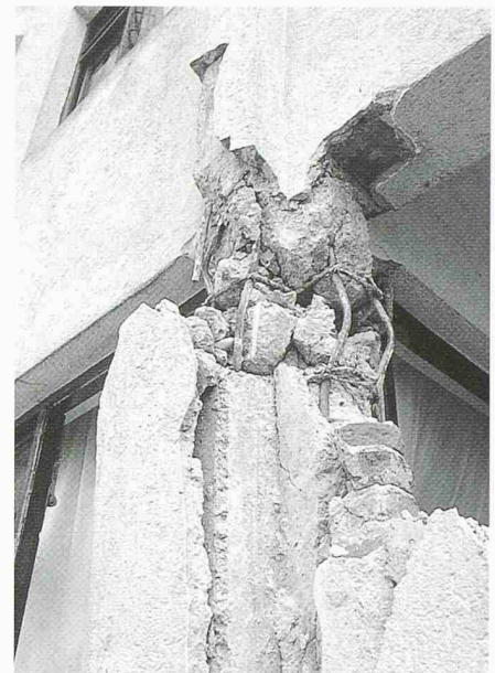
6 Konstruktionsdetail: Verbindung Stütze-Balken
