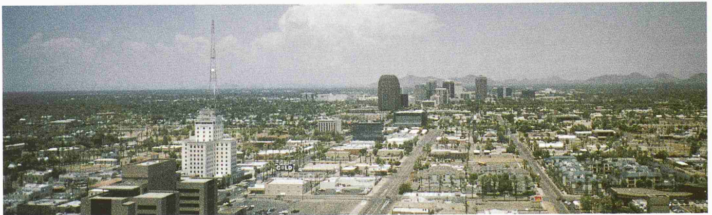
Stadt oder Supervorort? Phoenix besitzt zwei Zentren: ein altes, Verwaltung und Kultur (oben), sowie zwei Kilometer nördlich ein neues, Bürostadt, verbunden durch die Central Avenue (unten)
