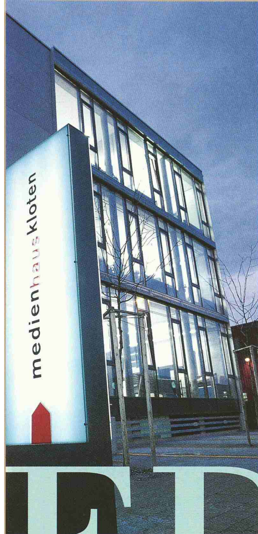
Medienhaus Kloten: 8 Unternehmen vernetzt unter einem Dach. Installation: E.Schibli AG, Kloten
