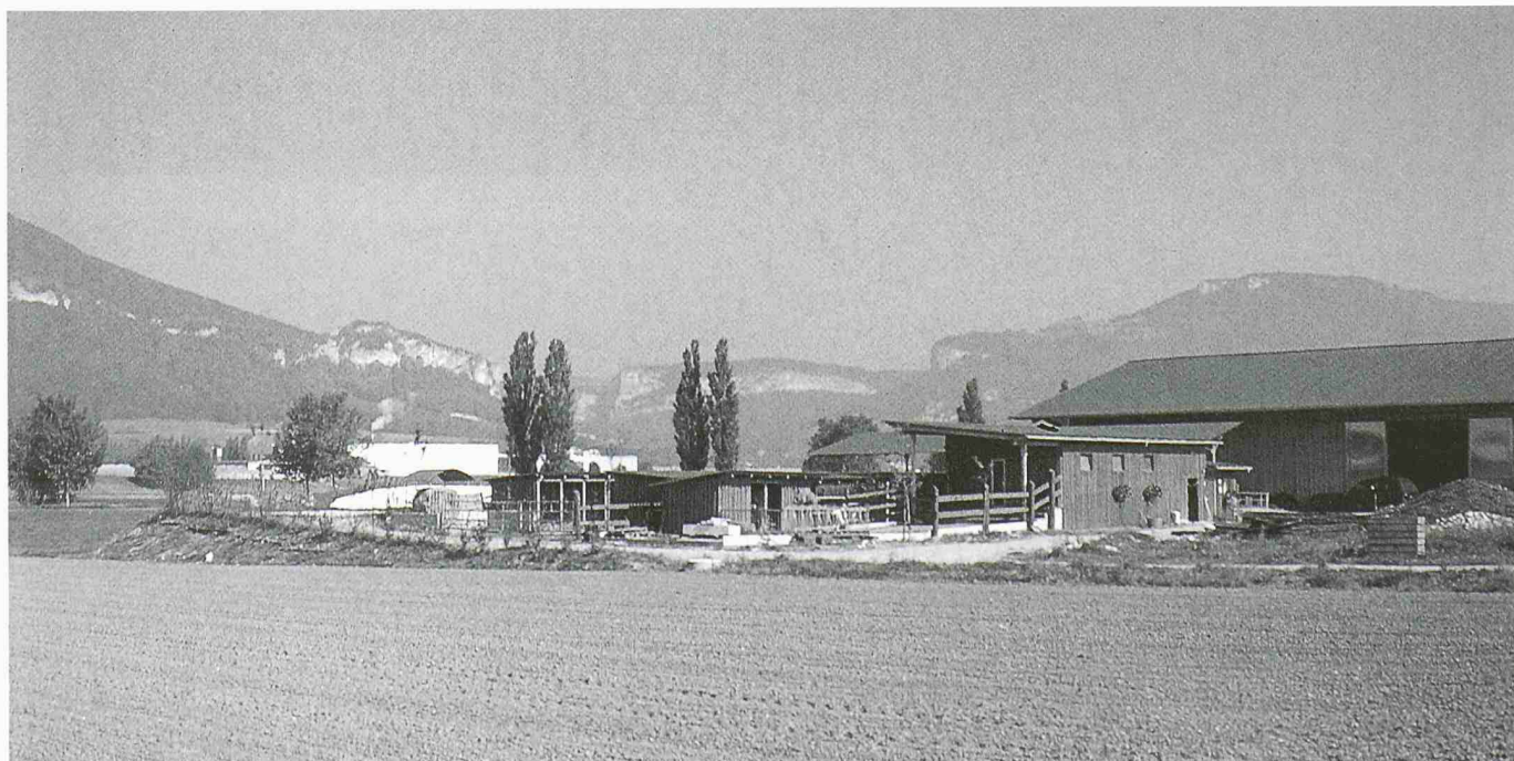
5 Die grosse Scheune sieht man von Weitem. Kaum sichtbar sind daneben die kleinen Hütten des Minimalstalls
