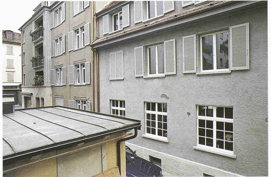
Sanierung Seefeldstrasse 172, Zürich. Alter Zustand links oben, Sanierter Putz unten. Farblich unterschieden sind zudem das Vorder- und das Hinterhaus
