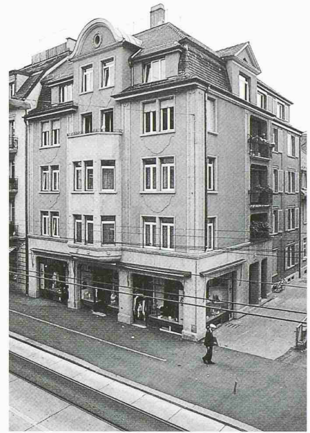
Sanierung Seefeldstrasse, Zürich, 1999
