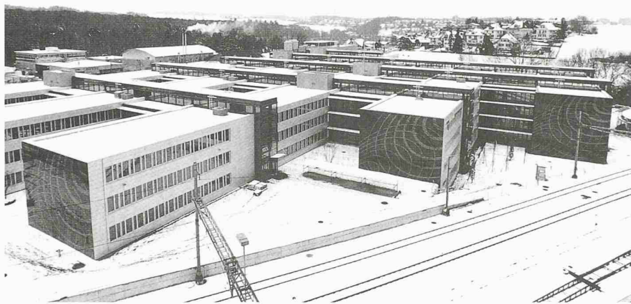
Swisscom-Verwaltungsgebäude Ittigen, 1995–1999, Architekten: Indermühle AG, Bern (Bild: Comet)
