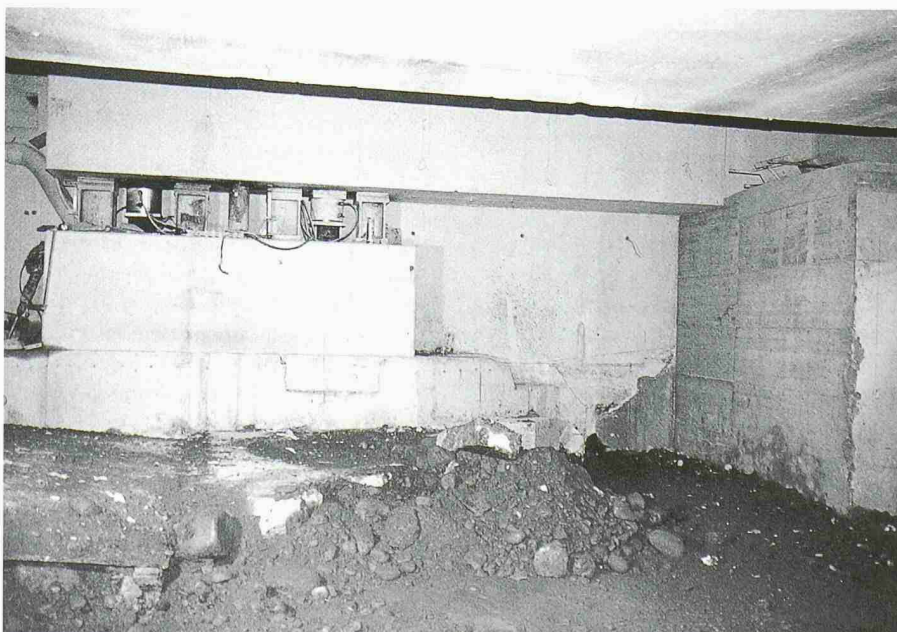
8 Fertiges Tragsystem mit Pfahlbankett, Pressensystem und Träger
