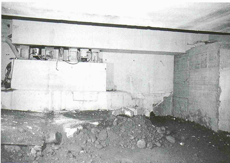
8 Fertiges Tragsystem mit Pfahlbankett, Pressensystem und Träger
