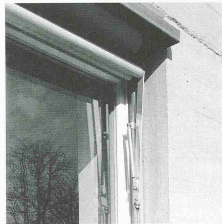
Detailaufnahme Fenstersturz bzw. -leibung nach den Sanierungsarbeiten nach Betonabtrag mit Wasserhöchstdruck
