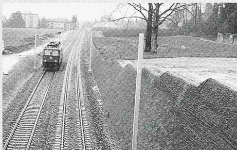
60° Steil- böschung neue Doppelspur MThB Kreuzlingen.
