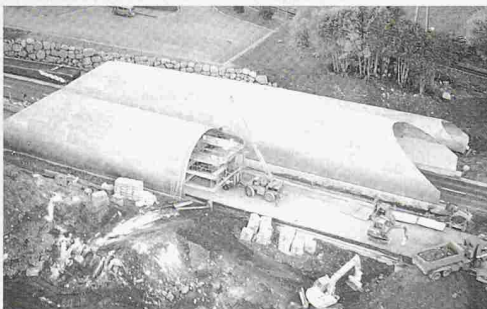
Wellstahlprofil 10,60/7,60 m Wildüberführung A8 Schindellegi
