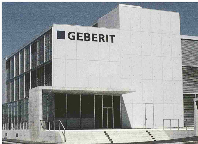
Die moderne Industriearchitektur des neuen Geberit-Informationszentrums stammt von Theo Hotz. Mehr als 4000 Fachleute und Auszubildende lernen hier jährlich die Verarbeitung und Handhabung der Geberit-Produkte kennen (Bilder: Geberit Vertriebs AG)
