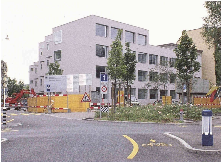
Die Heilpädagogische Schule an der Gotthelfstrasse in Zürich hat nach der Sanierung als erste städtische Liegenschaft das Minergie-Label erhalten (Bild: pd)
