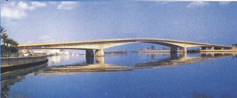
Giuliana Brücke: Verstärkung mit vorgespannter S&P Lamelle CFK Lybien
