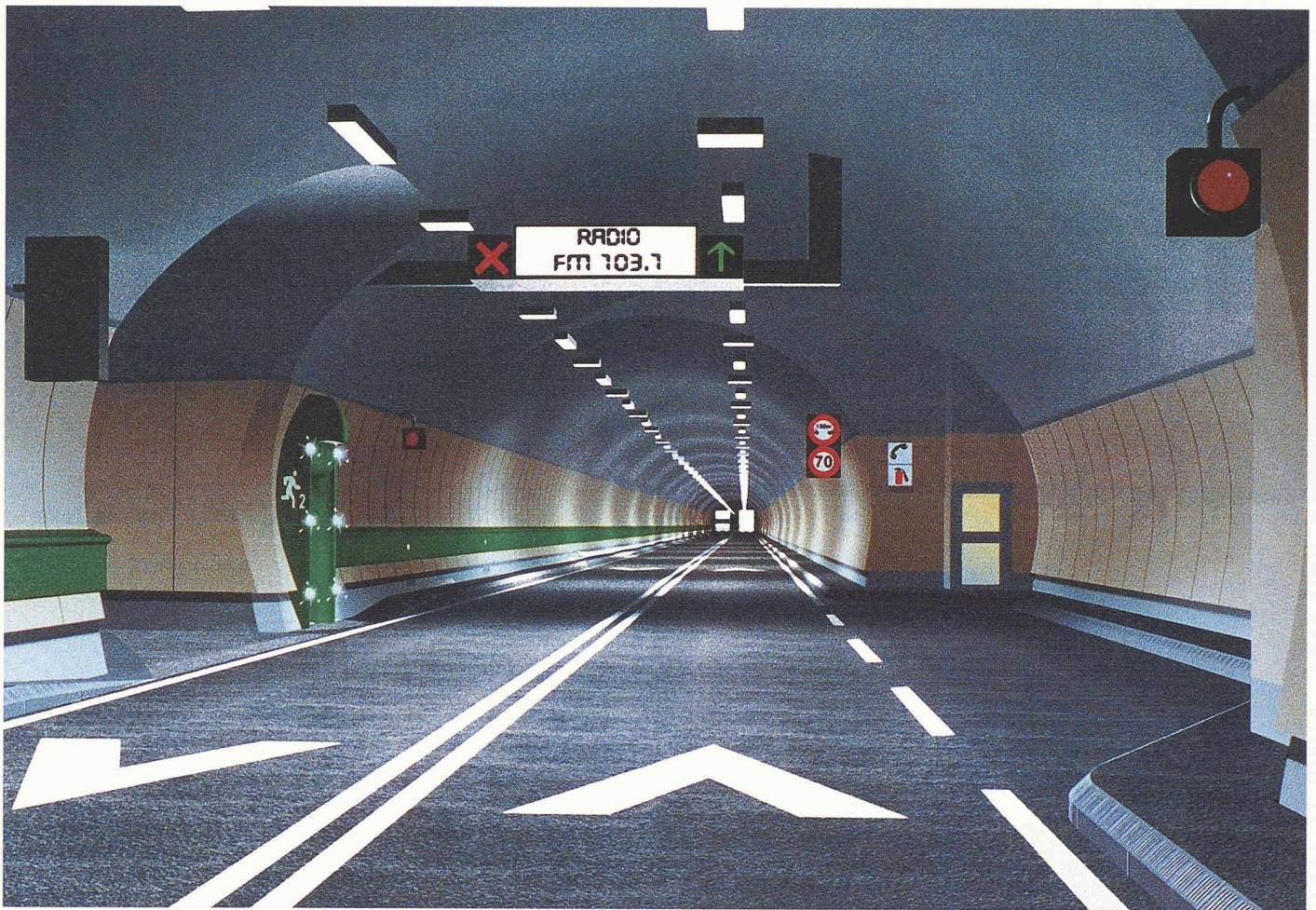
Alle 600 Meter befinden sich Schilder mit variablen Meldungen oder Piktogrammen, deren Information im Ereignisfall angepasst werden kann
