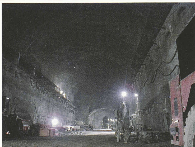
Aufnahme bei Halbzeit der Ausbruchsarbeiten der Zentrale Deriner – Türkei ( H = 25 m, B = 30 m, L = 120 m )
