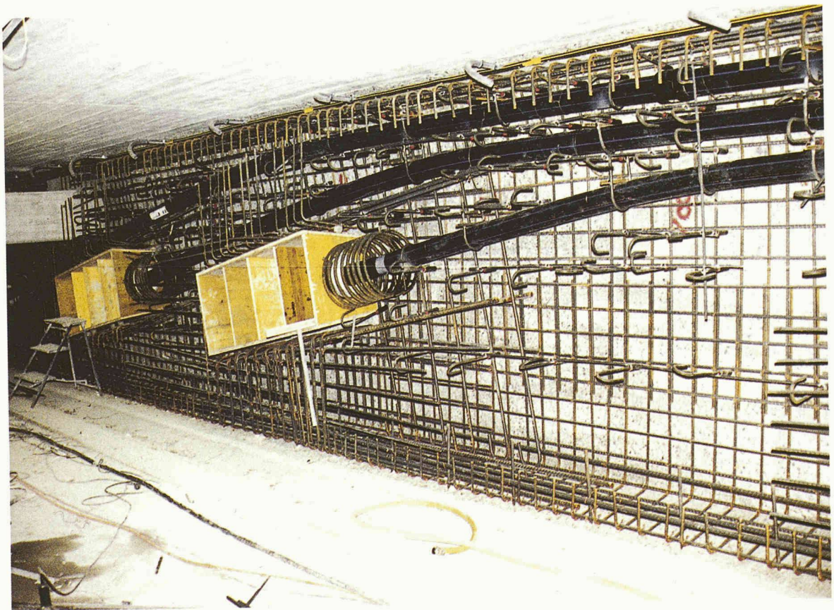
Endverankerung mit Stegvorbetonierung, provisorische Kabelhalter am Steg
