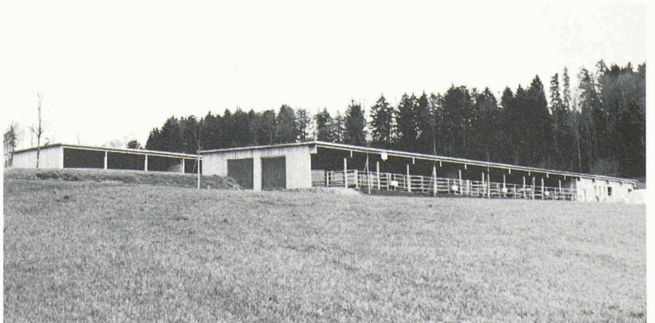
Die zwei parallelen, eingeschossigen Stallbauten. Benützt wurden nur natürliche Materialien, nämlich unbehandeltes Holz und Beton. Auf der rechten Seite der Grundriss
