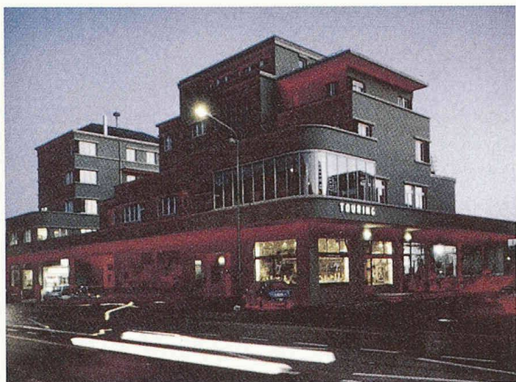
Nach der Sanierung: das «Touring» by night (Bild: Alain Stouder, Solothurn)
