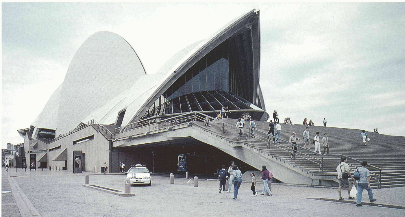
Einstieg in die Treppenanlage mit darunter liegender Autozufahrt
