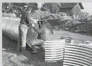
Montage eines HAMCO-Wellstahlrohres in Ermensee, Kt. Luzern.
