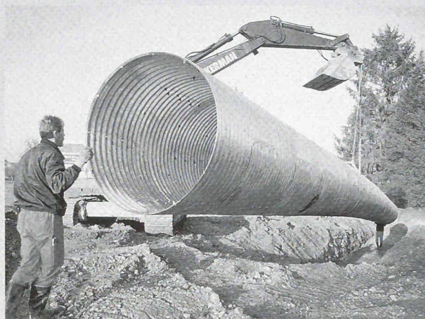
Montage eines HAMCO-Wellstahlrohres in Ermensee, Kt. Luzern.
