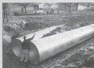
Montage eines HAMCO-Wellstahlrohres in Ermensee, Kt. Luzern.
