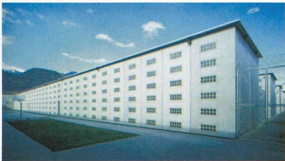
Von links: Untersuchungsgefängnis Sion (1998), ausgezeichnet mit dem Betonpreis 01
