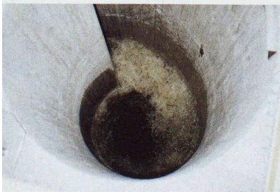
Wirbelfallschacht in der Betriebszentrale Glatt. Die durch den Fall des Abwassers in den gut 6 m tiefer gelegenen Überleitungsstollen entstehende Energie wird zur Schonung der Bauteile mit der Verwirbelung vernichtet
