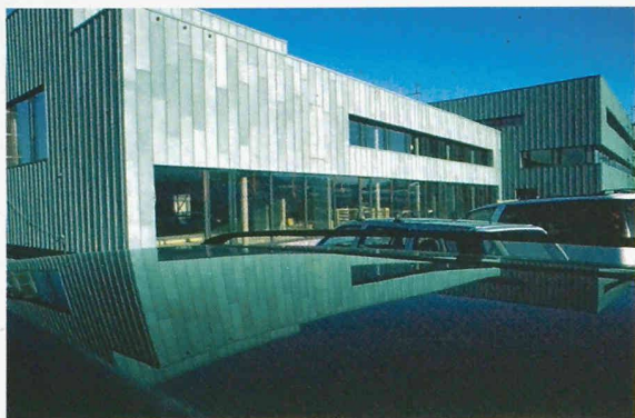
Metas-Erweiterungsbau: Kupferfassade mit eingesetzter Filterschicht (Bild: Metas)
