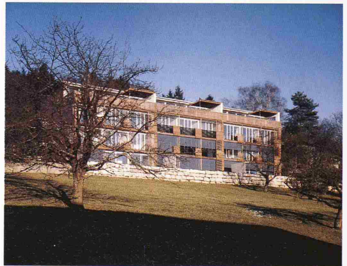
Passivhaus «Sunny Woods» am Stadtrand von Zürich. Sichtbar ist nur das Holz der Fassade. Aber auch Wände und Decken bestehen aus nachwachsendem Baustoff. Die Solaranlage auf dem Dach liefert einen Teil des benötigten Stroms (Bild: Beat Kämpfen)
