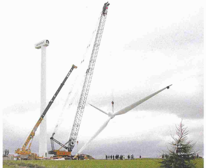
Montage des Rotors an einer 850-kW-Turbine auf dem Mont-Crosin. Nabenhöhe: 50 Meter. Rotordurchmesser: 52 Meter. Geschätzte Jahresproduktion: 900 MWh (Bild: Juvent)
