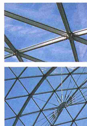
Atriumdach der DG-Bank, Berlin; Arch.: Frank O. Gehry, Santa Monica; Innenansicht, Speichenrad, Dreiecksmasche
