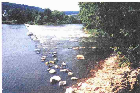
Fischrampe Lahnwehr Bad Ems (D, Rheinland-Pfalz) Höhenunterschied: 3 m; Länge: 60 m, Gefälle: 5 %, Breite: 20 m, Abfluss: 3,5 m 3 /s. Die Fischrampe ist im spitzen Winkel zwischen Wehr und Ufer angelegt (Bild: Rolf-Jürgen Gebler)
