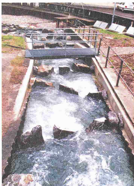
Raugerinne-Beckenpass Schwellenmätteli in Bern (Bauherr: EWB). Höhenunterschied: 2,5 m; Länge: 37,5 m; Gefälle: 7 %; Breite: 2,5–3,5 m; Abfluss: 0,7 m 3 /s. Dieser Raugerinne-Beckenpass wurde in einer bestehenden Leerschuss-Rinne am oberen Ende des Wehres errichtet (Bild: Rolf-Jürgen Gebler)
