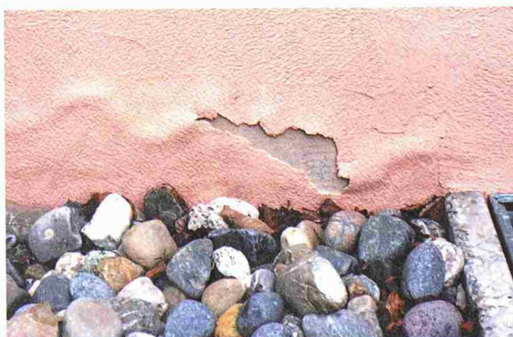
Putzablösungen in der Sockelzone durch fehlenden Schutz unter der Terrainoberfläche (Bilder: Jürg Pfefferkorn)
