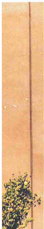
Spannungsrisse an Sturzecke
