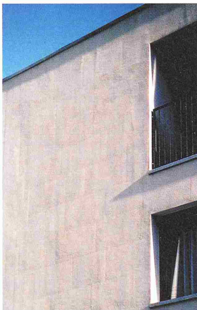
Im Streiflicht erkennbare Unebenheiten, die nicht auf einen technischen Mangel zurückzuführen sind, aber immer häufiger beanstandet werden
