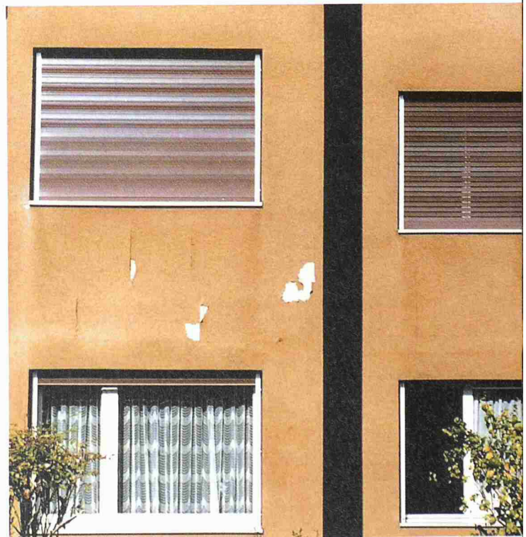
Risse in der Fassade führen durch eindringendes Wasser zu Abplatzungen des Verputzes
