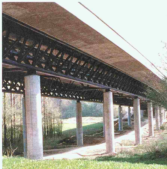
Zukunftsträchtige Konstruktion: Ein Fachwerk aus verschweissten Stahlrohren trägt die Fahrbahnplatte aus Beton bei der Autobahnbrücke von Lully (FR) (Bild aus Dokumentation SIA D 0173)
