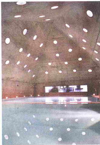
Beim pyramidenförmigen Badehaus der Rehab-Klinik Basel wurde für die Abdichtung das Contec-System angewendet
