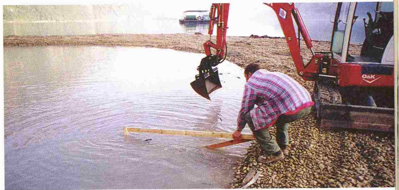
Die Ringinsel im Bau (Bild: P. Regli)
