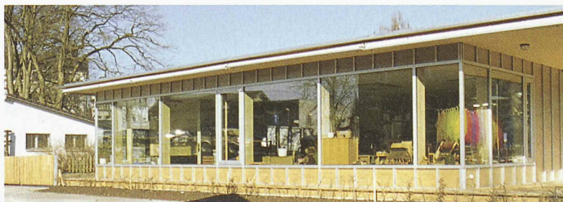
Der Kindergarten in Wil SG ist ein Passivhaus aus Holz (Architektur: Grob und Schöpfer)
