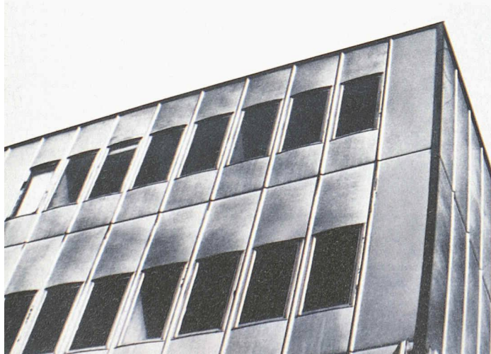
Metallfassade Maison du Peuple in Paris-Clichy von Jean Prouvé (1938–39)
