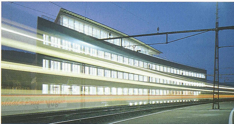
Metron: Wohn- und Geschäftshaus Stahlrain, Brugg, 1985–93 (Bild: Metron, Brugg)
