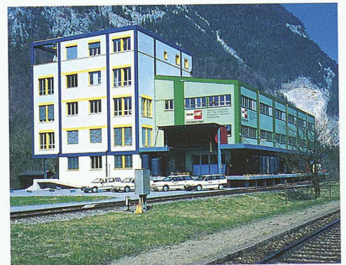
Das Betriebsgebäude der Liebi LNC AG im Burgholz, nur fünf Minuten von der Autobahnabfahrt Wimmis entfernt, an der Pforte zum Simmental.
