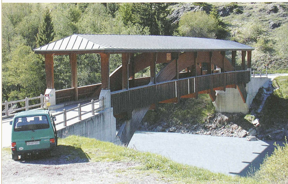
Das Dach bietet einen guten konstruktiven Holzschutz, Ramosch (GR) (Bilder: Empa)
