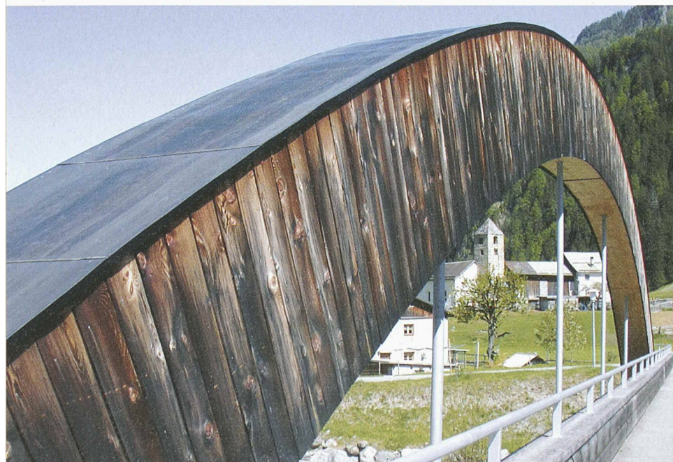
Die Hauptträger sind durch Bleche und Abdeckbretter geschützt
