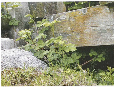
Pflanzen verzögern nach einer Schlechtwetterperiode die Austrocknung des Holzes
