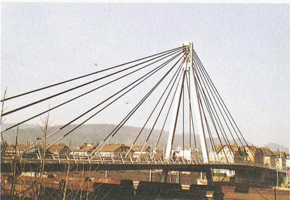
Bei der Storchenbrücke, die den Rangierbahnhof Winterthur überspannt, wurden erstmals versuchsweise zwei Schrägseile aus Kohlefasern anstatt aus Stahl eingebaut (Bild: pps)
