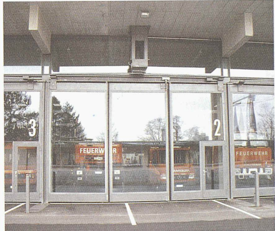
grösste verglaste Falttorflügel Europas
