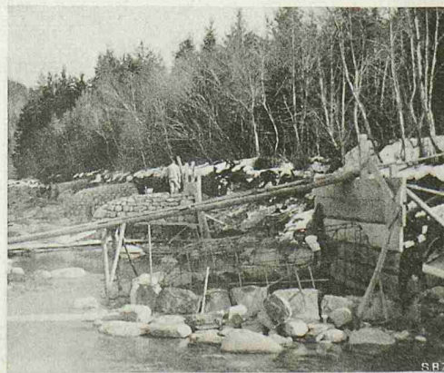
Abb. 14. Armieren und Verkleiden von Schildkröten
