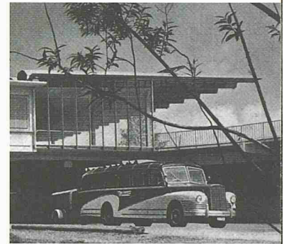
Vordach von A. & H. Oescher (Bild: «Schweizerische Bauzeitung», Bd. 71, Nr. 35, 1953)
