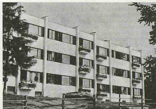
Auch da gibt es eine rechteckige Grundordnung, die vielfach variiert wird: die Horizontalen sind an einer Stelle abgesetzt, die Träger springen aus der glatten Wand vor und über die Dachlinie hinaus und sind in verschiedenen Abständen dazu gesetzt. Alvar Aalto, Wohnhaus Sunila, Finnland
