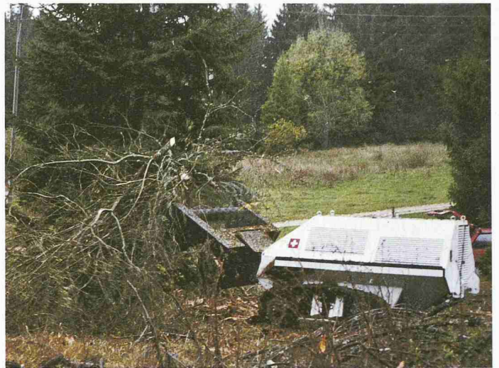
Der ferngesteuerte Digger räumt mit seinen Kettenpeitschen Strauchwerk weg und bringt Minen zur Explosion (Bilder: pps)
