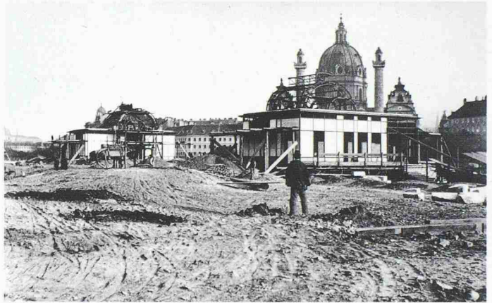
«Alt-Wien war einmal neu.» (Karl Kraus) Bau der Stadtbahnstation Karlsplatz in Wien 1899 (Bild: Friedrich Strauss, Wien Museum)
