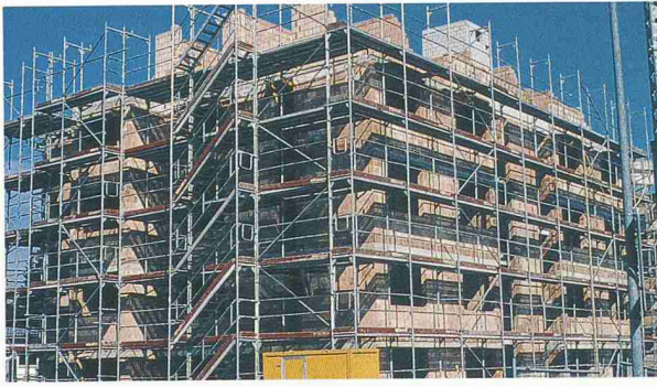
Mauerwerksbau mit problematischem Erdbebennachweis
