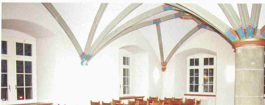
6 Mensa der Pädagogischen Hochschule in Rorschach mit schallabsorbierender Decke (Akustikputz mit Mineralfaser), 2003: Denkmalschutz und Akustikmassnahme in einem
