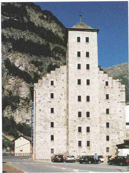
Der Stockalperturm in Gondo VS: nach der Instandstellung mit Sälen, Museum und Café (Bild: SHS)
